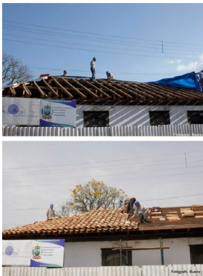
FIGURA 1 - Restauro do telhado do Museu do Tropeiro - 2014. FONTE: Márcio Bueno.
