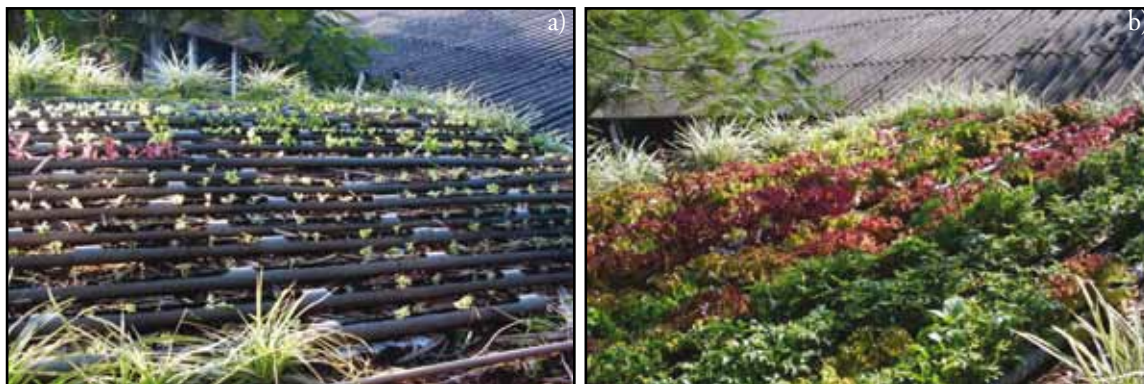
Figura 2 – Cobertura do telhado com sistema de cultivo com utilização tubos de PVC sobre cobertura morta (bagaço de cana ou fibra de côco), aspecto durante o plantio (a) e colheita (b).
