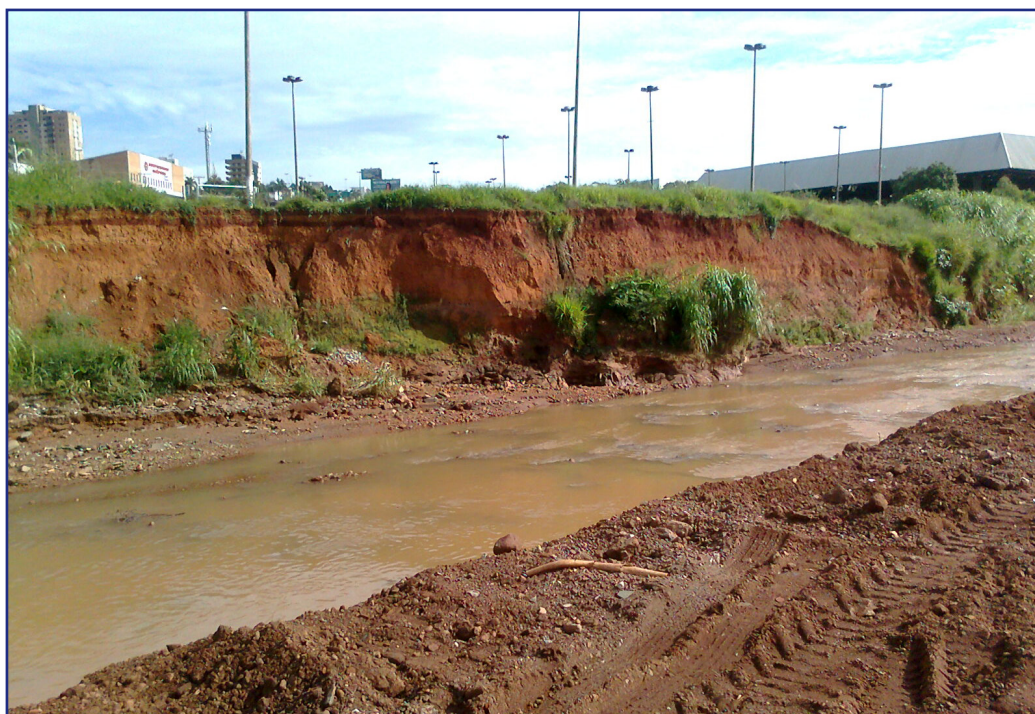
FIGURA 4: Trajeto do córrego das Antas próximo a construções.
