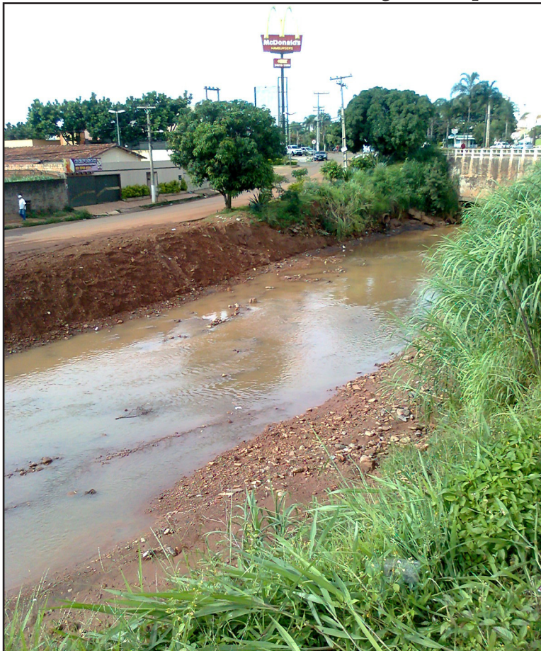
FIGURA 3: Visita técnica ao caminho das águas (Anápolis-GO).
