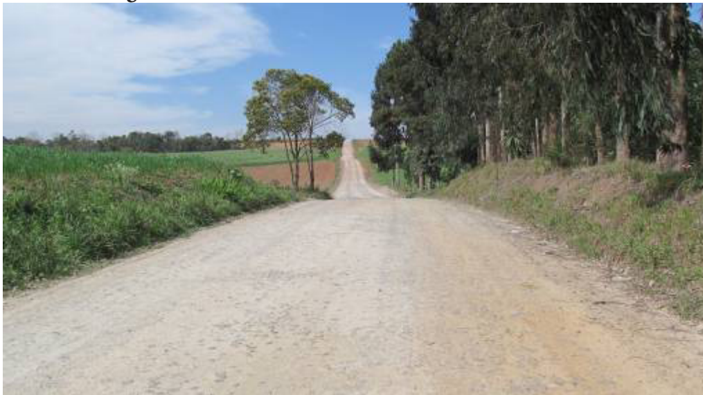
Figura 1 – Estrada rural: acesso às localidades de coleta
