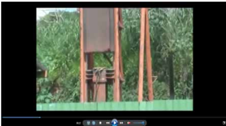
Figura 2 – Cravação de estaca com auxílio de um bate-estaca
