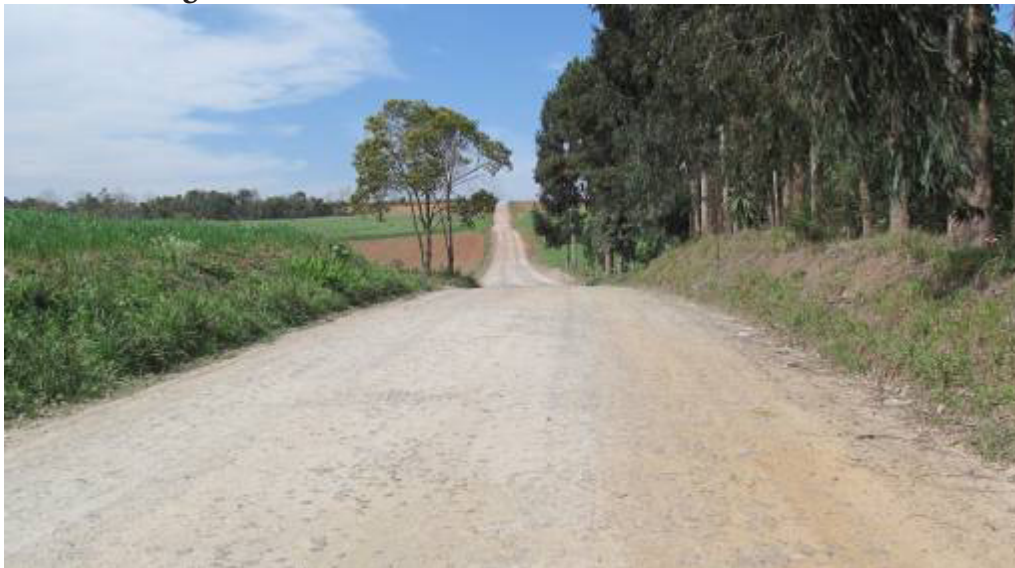
Figura 1 – Estrada rural: acesso às localidades de coleta
