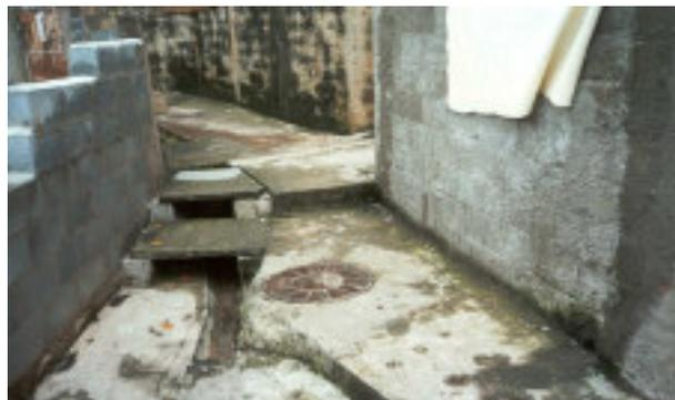
Figura 8 – Dispositivos das redes de infra-estrutura e sistema viário – conflito e excesso de equipamentos em apenas uma viela de pedestres.
