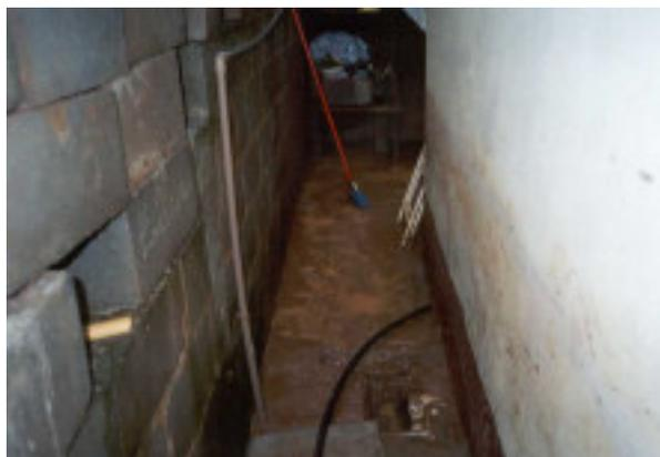
Figura 5 – Interferência entre a tubulação de água potável e a caixa de inspeção no corredor lateral da moradia.
