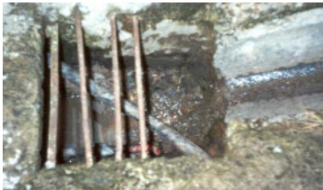
Figura 7 – Sobreposição da rede de abastecimento de água e do sistema de drenagem de águas pluviais
