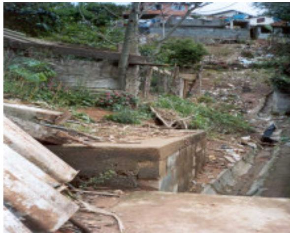
Figura 6 – Vista da área particular onde foi implantado o trecho de jusante da rede, sem acesso para equipes de manutenção
