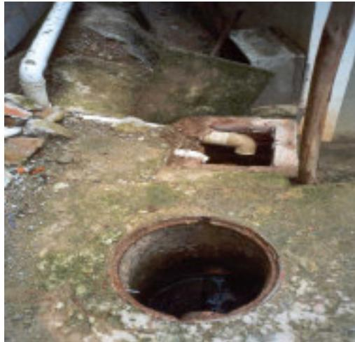
Figura 3 – Tubulação predial de esgoto aparente, com execução bastante precária. Notar também o cavalete de água potável em nível inferior à rede de esgoto
