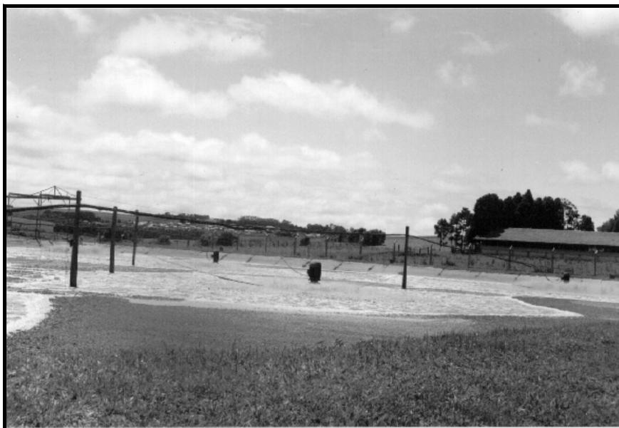
Figura 4 - Lagoa aeróbia de tratamento de manipueira em fecularia paranaense de grande porte.
