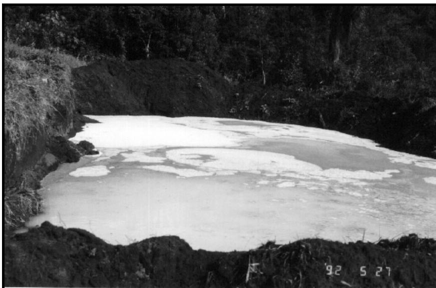
Figura 6 - Lagoa de contenção em fecularia paranaense de pequeno porte, evidenciando a camada superficial de microrganismos.
