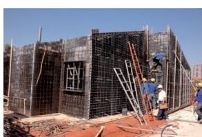
Figura 7 – Montagem das fôrmas Fonte: Os autores (2009)
