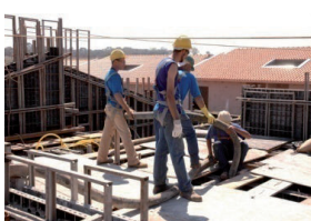
Figura 8 – Concretagem Fonte: Os autores (2009)
