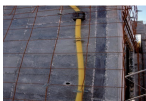
Figura 6 – Instalação da tubulação da parede Fonte: Os autores (2009)
