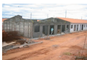
Figura 9 – Desmontagem das fôrmas Fonte: Os autores (2009)
