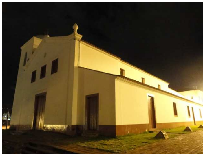
Foto 2 - Em primeiro plano, a Capela de São Benedito anexada à Igreja de Nossa Senhora do Rosário, o que deu origem à denominação de “Igreja de Nossa Senhora do Rosário e de São Benedito”
