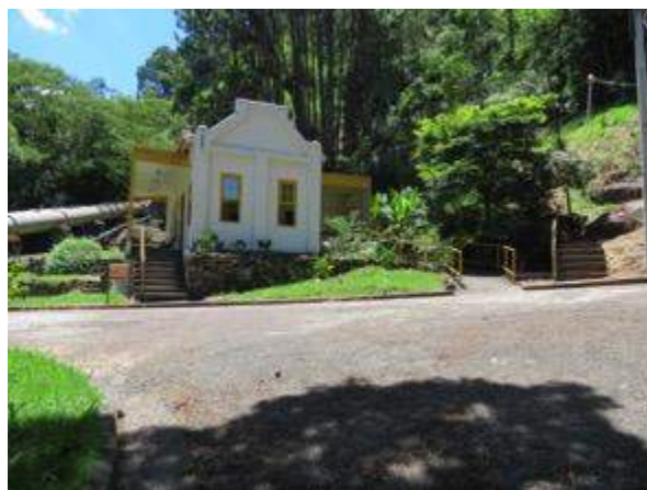
Figura 1. Museu da energia de Salesópolis – Casa das Máquinas
