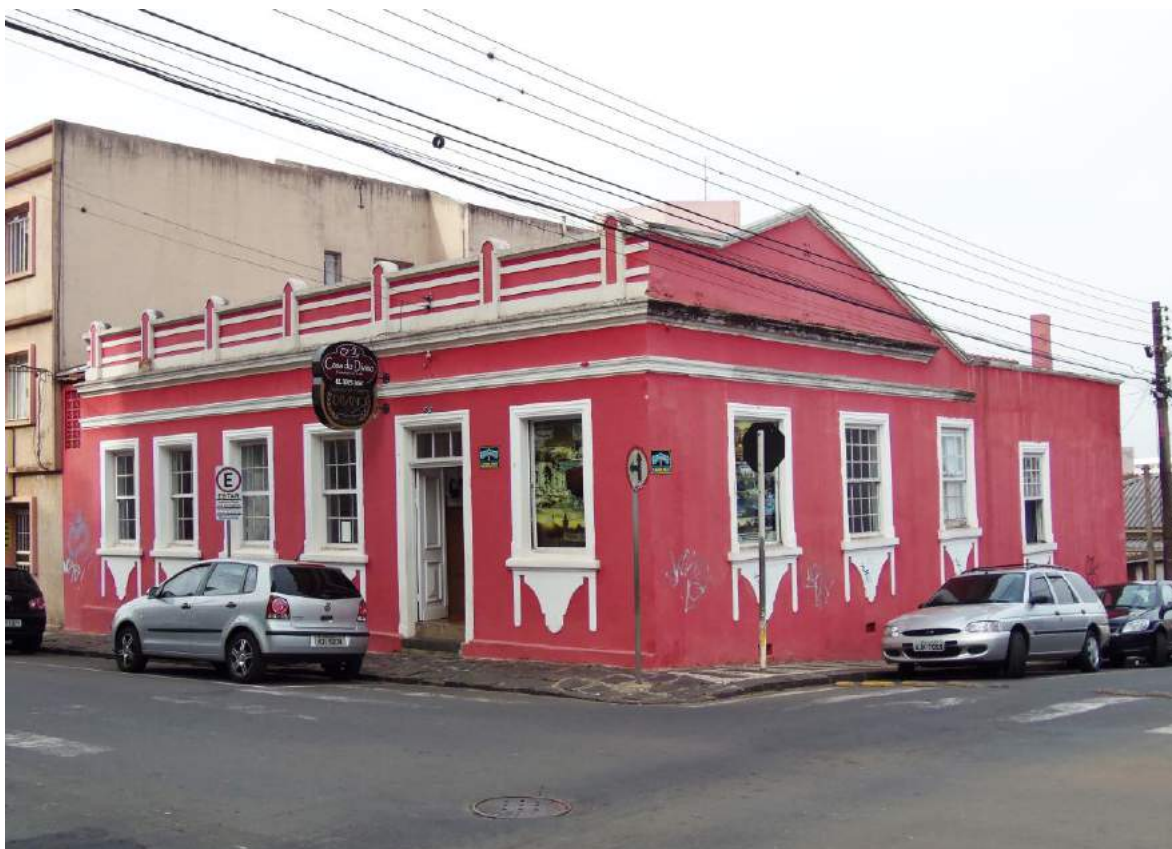
Legenda 1: Casa do Divino. Local de devoção ao Divino Espírito Santo desde 1882. Situada na Rua Santos Dumont nº 524, na cidade de Ponta Grossa (PR).
