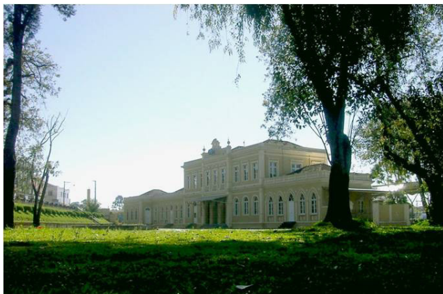
Figura 6 – Estação São Paulo-Rio Grande
