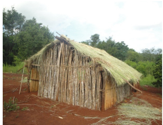
Imagem 4 - 5 - Construção de residência ‘tradicional’ no Tekoha Añetete. Detalhe: o uso de capim santa fé na cobertura, paredes de roliços e amarrações de cipó. Em dezembro de 2012
