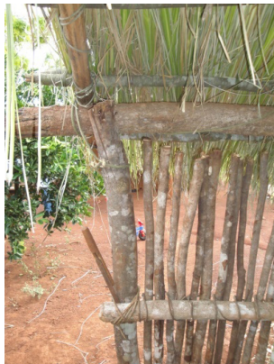
Imagem 4 - 5 - Construção de residência ‘tradicional’ no Tekoha Añetete. Detalhe: o uso de capim santa fé na cobertura, paredes de roliços e amarrações de cipó. Em dezembro de 2012
