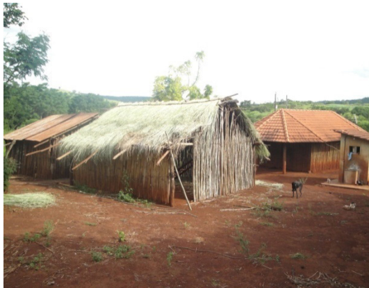
Imagem 4 - 5 - Construção de residência ‘tradicional’ no Tekoha Añetete. Detalhe: o uso de capim santa fé na cobertura, paredes de roliços e amarrações de cipó. Em dezembro de 2012
