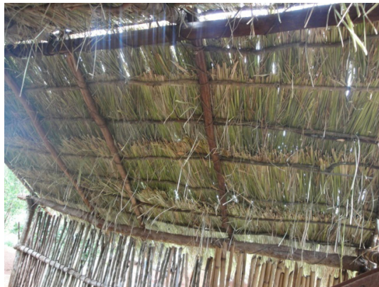
Imagem 4 - 5 - Construção de residência ‘tradicional’ no Tekoha Añetete. Detalhe: o uso de capim santa fé na cobertura, paredes de roliços e amarrações de cipó. Em dezembro de 2012
