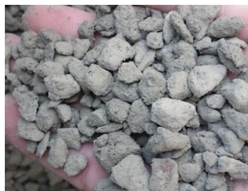
Figura 4. Concreto sem coesão, evidenciando falta de água no traço.
