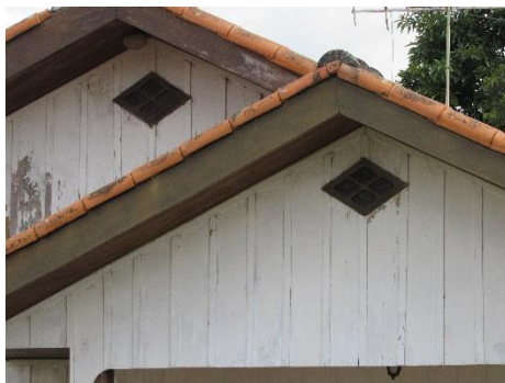
Figura 5 - Dispositivos de ventilação da caixa de ar nos oitões Fonte: foto do autor, abril de 2016
