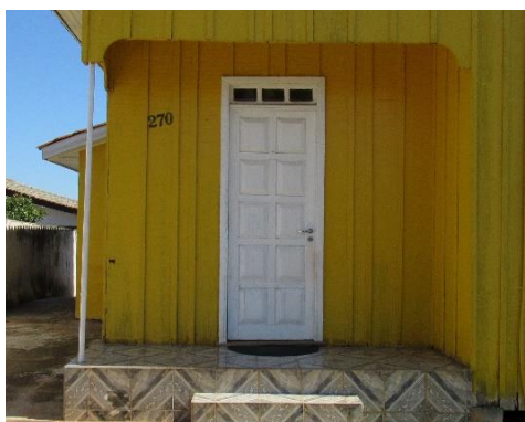
Figura 6 - Porta de madeira almofadada Fonte: foto do autor, julho de 2016
