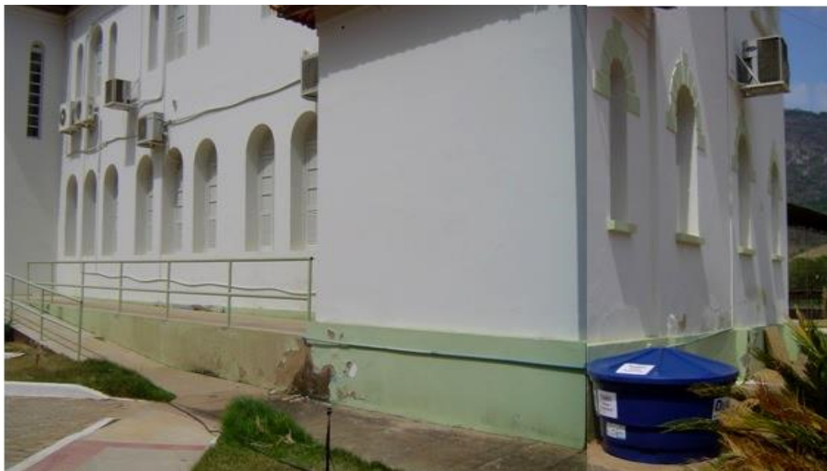
Figura 4 – Caixa de água de 1.000 litros destinada ao armazenamento da água. Foto: Elvis Pantaleão Ferreira (2015).
