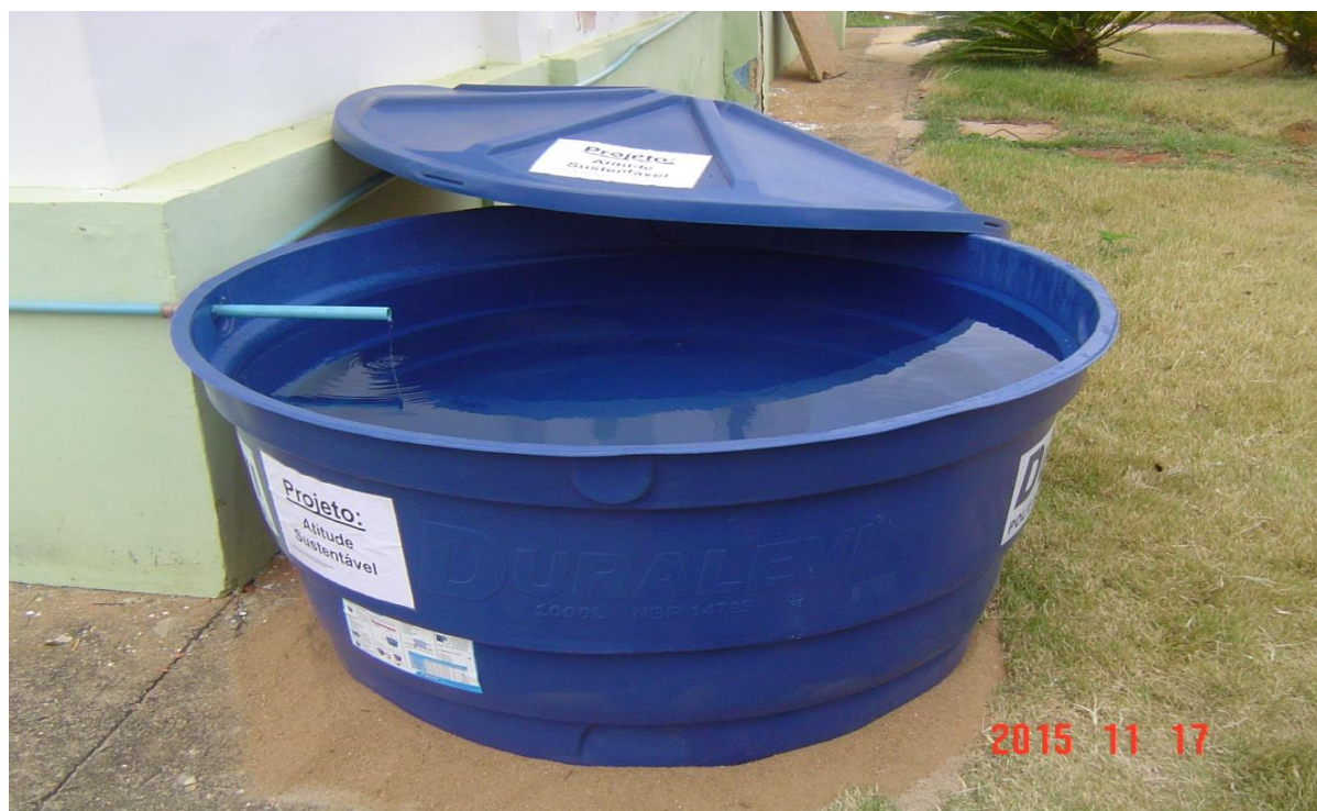
Figura 5 – Caixa de água de 1.000 litros destinada ao armazenamento da água. Foto: Elvis Pantaleão Ferreira (2015).
