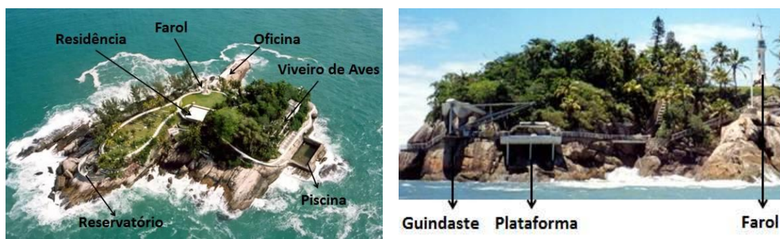
Figura 2 - Principais construções presentes na Ilha dos Arvoredos (Google, 2015).
