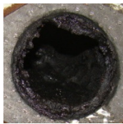
2a. Duto de escape do E-1
