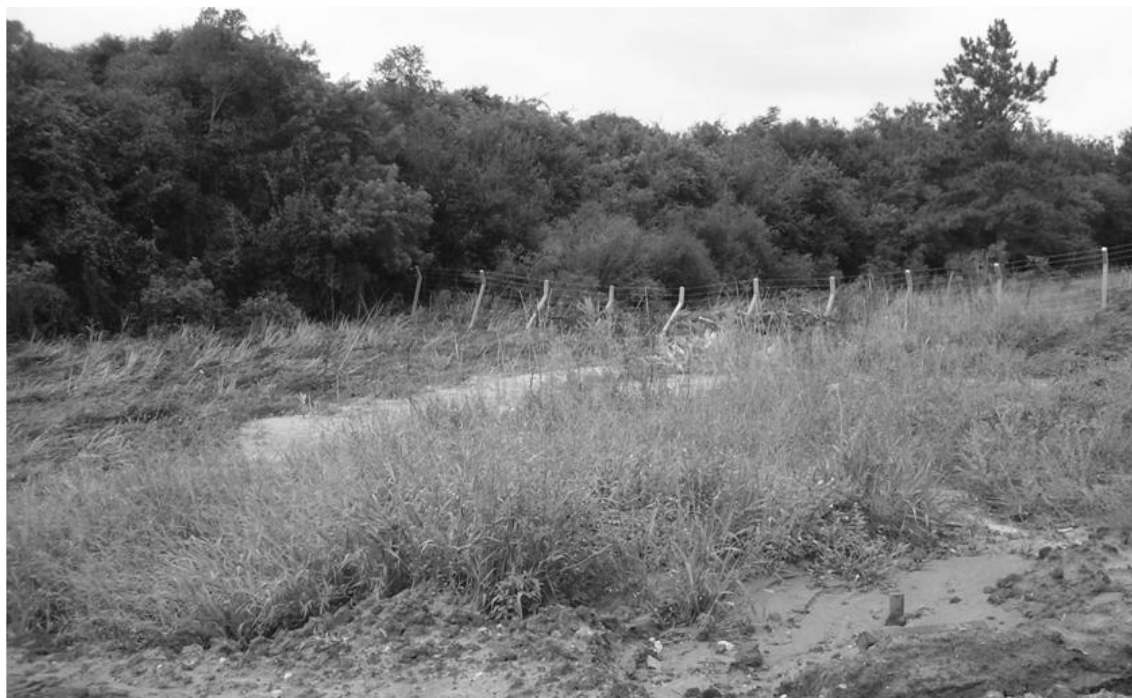
Figura 3 – Cerca da divisa danificada pela cheia do Rio Cará-Cará
