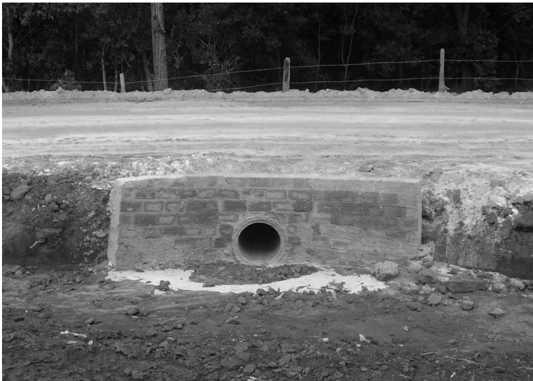
Figura 6 – Drenagem no acesso
