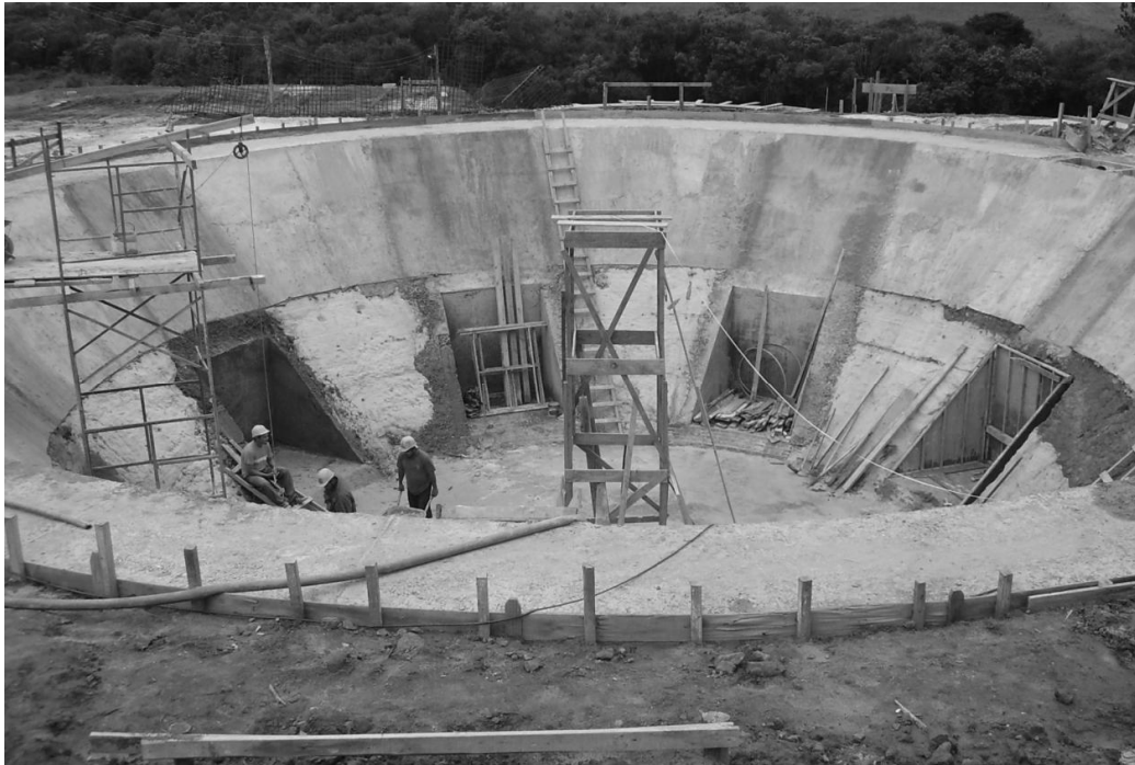
Figura 5 – Revestimento do talude e nichos para sapatas de fundação no Ralf
