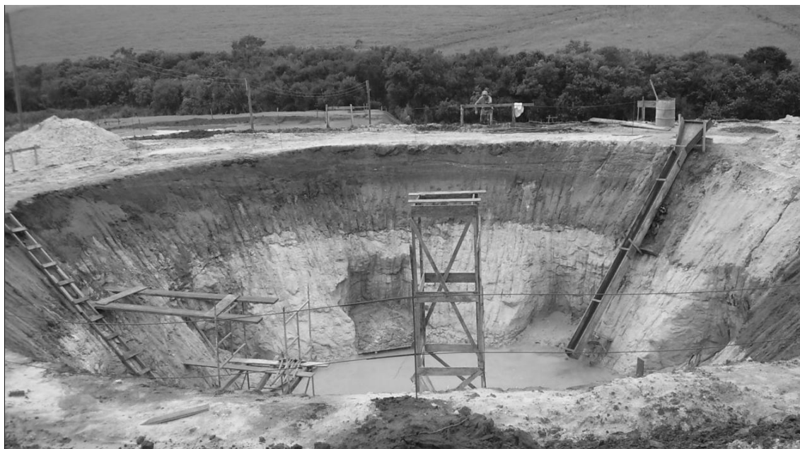
Figura 4 – Escavações no Ralf
