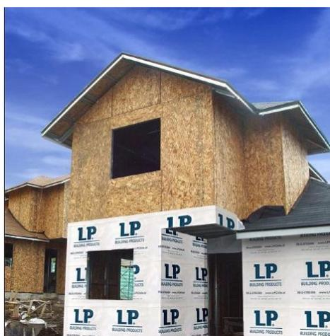
Figura 3 – Aplicação de membrana hidrófuga (LP, 2011)
