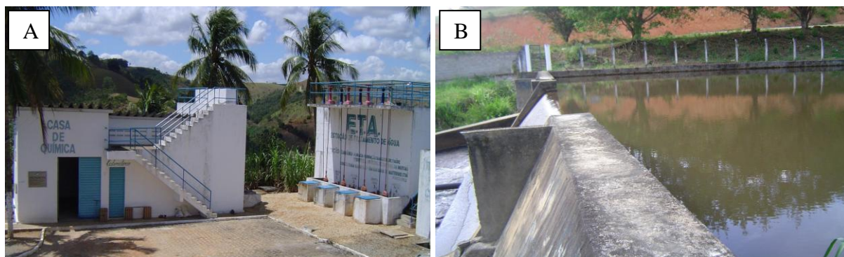
Figura 2 – (A) Vista parcial da Estação Convencional de Tratamento de Água. (B) Vista parcial da barragem de captação de água bruta.
