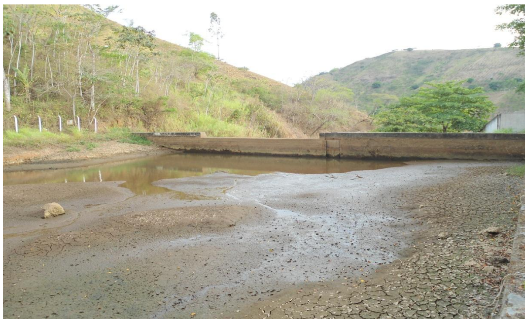
Figura 3 – Nível de água crítico registrado em Dez/2012 na barragem de captação de água bruta.
