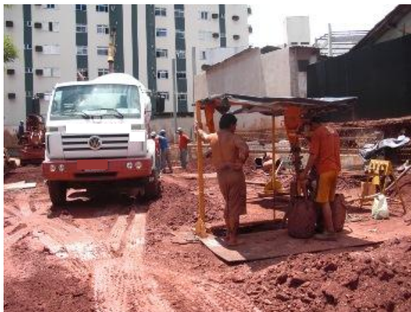
Figura 4 – Proximidade na execução de serviços de concretagem e alargamento da base de tubulões.
