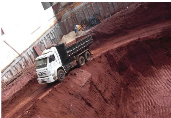
Figura 6 – Caminhão próximo ao talude.
