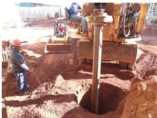
Figura 2 – Perfuração do Fuste de Tubulões.
