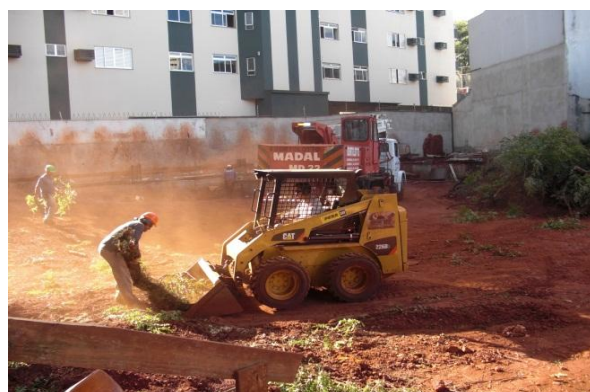
Figura 1 – Preparo do canteiro-de-obras.
