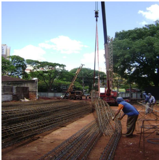
Figura 5 – Transporte de ferragens com guindaste e acompanhamento de colaborador.
