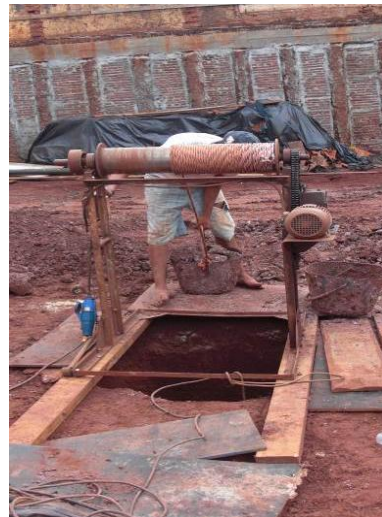
Figura 3 – Alargamento da base dos tubulões.
