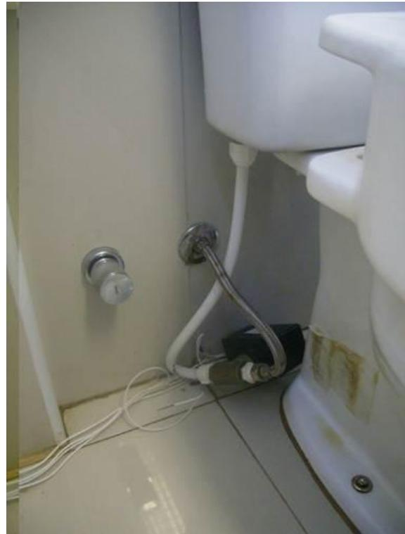
Figura 02: chave de fluxo instalado no ponto de consumo-bacias sanitárias
