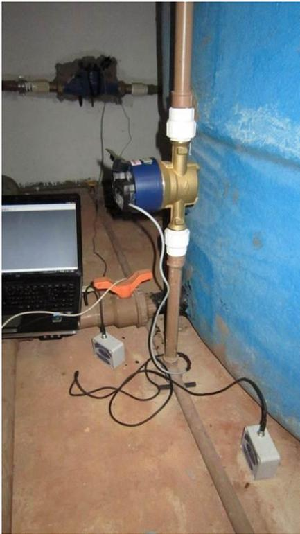
Figura 01: Coleta de dados na entrada de água potável do reservatório inferior de água pluvial
