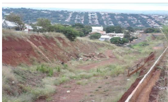
Figura 02 – Escavações no Contorno Norte em fase de execução.
