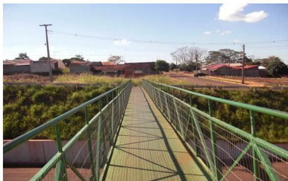
Figura 16 – Travessia do vão do Contorno Norte com 11m de altura.
