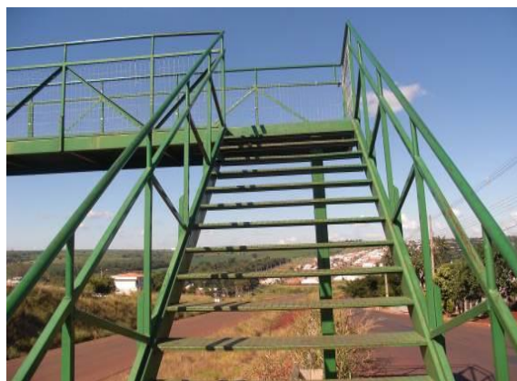
Figura 15 – Visão da primeira etapa de subida da passarela provisória.
