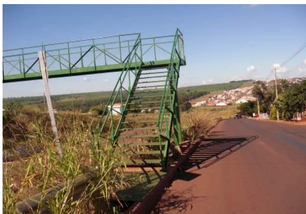
Figura 14 – Início da passarela do Contorno Norte.
