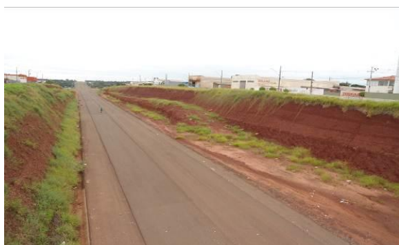
Figura 01 – Escavações no Contorno Norte - Trecho entre o Loteamento Sumaré e o Jardim Colina Verde.
