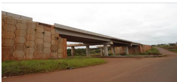
Figura 10 – Ponto nodal: Cruzamento por viadutos.
