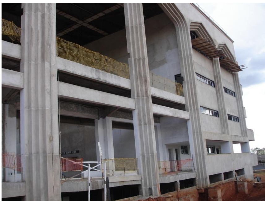
Figura 7 - Detalhes dos pilares da edificação
