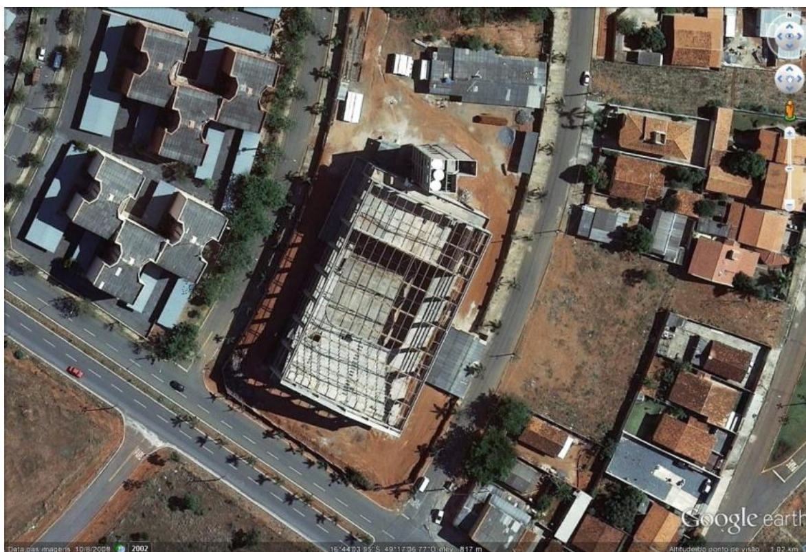
Figura 1 - Foto aérea da edificação.
