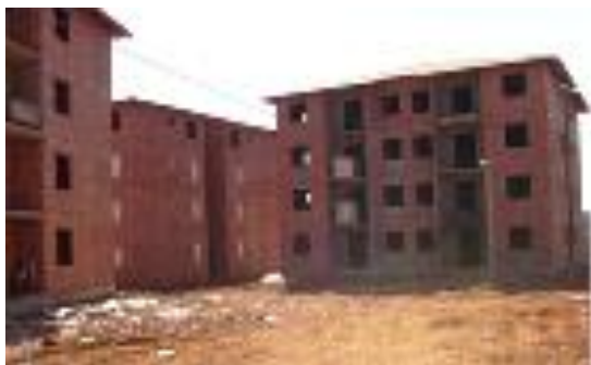
Figura 5 – Prédios em alvenaria estrutural Fonte: autor
