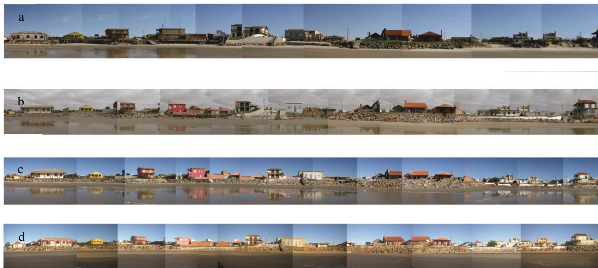
Figura 6 - Mosaicos de fotografias de um trecho centro norte da orla do Balneário em (a) 28/8/2009, (b) 22/11/2010, (c) 5/12/2011 e (d) 23/12/2013, obtidas a partir da linha de baixa mar, mostrando a expansão da contenção com enrocamento e blocos pré-moldados de concreto.
