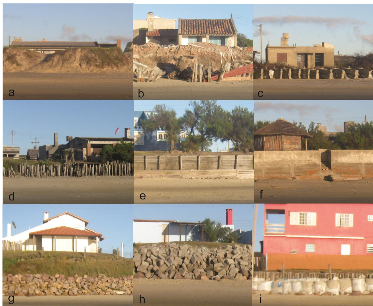
Figura 4 - Fotos das diferentes estruturas de contenção a erosão utilizadas no balneário do Hermenegildo: a) dunas frontais, b) resíduos da construção e demolição, c) pneumáticos, d) postes de madeira, e) muros de madeira, f) muros de concreto, g) enrocamento, h) blocos pré-moldados de concreto e i) areia e concreto ensacado.
