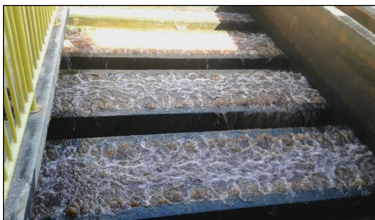
Figura 3 – Realização da lavagem dos filtros da ETA. Fonte: Próprio autor.
