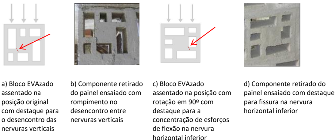
Figura 11: Identificação dos problemas de geometria do componente comprometendo o seu desempenho mecânico
