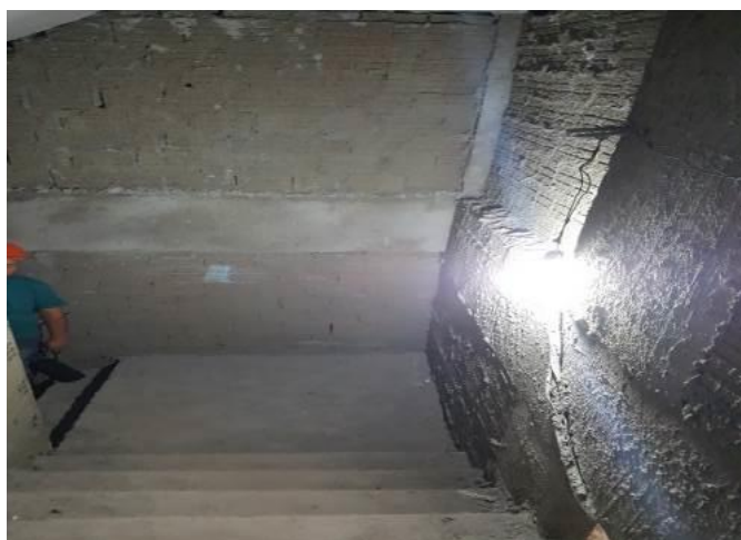
Figura 14 - Iluminação na escadaria.
