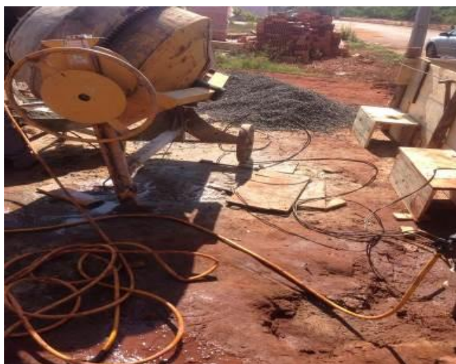
Figura 11 – Alimentação de uma betoneira
