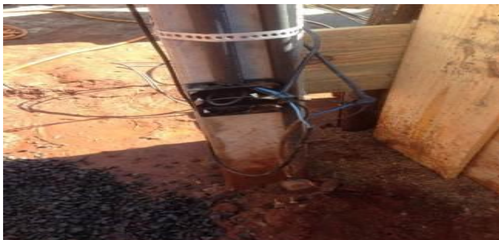
Figura 9 - Metodo inadequado de ligacao.
