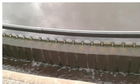
Figura 6 - Efluente tratado no final do decantador.
