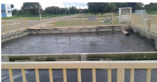
Figura 5 - Vista lateral zona anaeróbia, anóxica do reator de lodos ativados.
