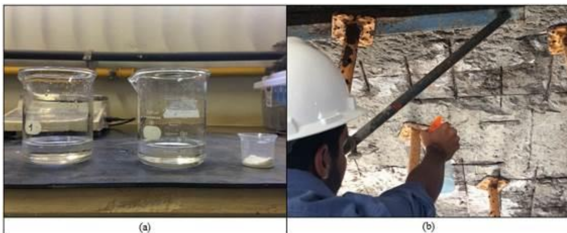
Figura 4 – Ensaio de profundidade de carbonatação: (a) Preparação da solução de fenolftaleína em laboratório; (b) Aspersão da solução em laje de concreto armado apicoada. Fonte: autores (2018).
