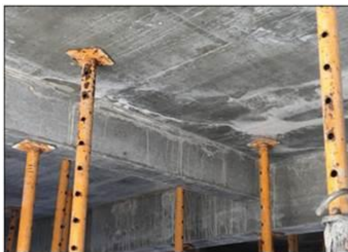
Figura 9 – Recuperação de laje e vigas de concreto armado. Fonte: autores (2018).
