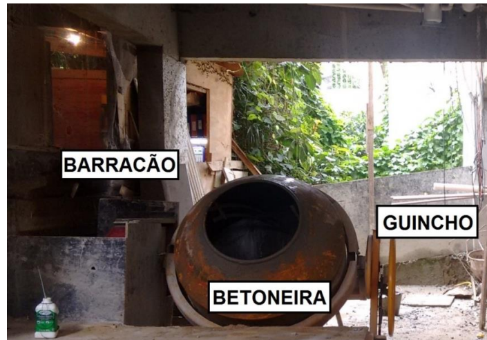
Figura 1 - Canteiro de obras
