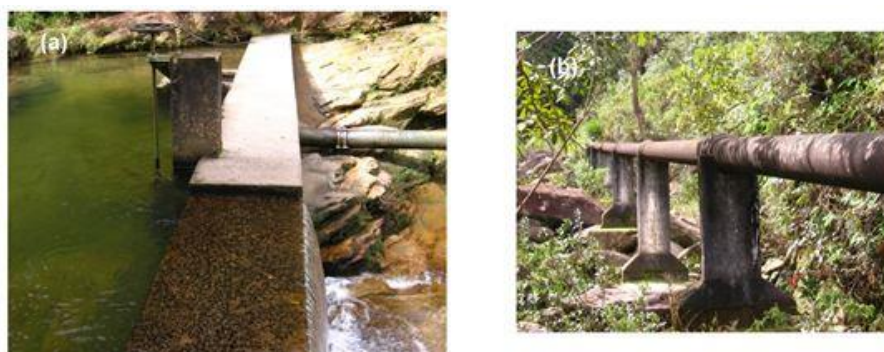
Figura 03 — Ponto de captação de água em (a), e transporte via dutos metálicos até a ETA—Itacolomi (adução) (b). (Fonte: Autor).
