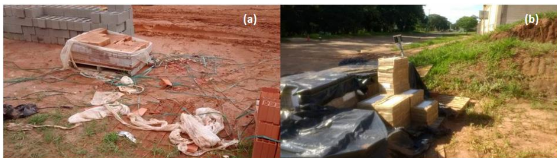
Figura 1: Armazenamento de materiais: (a) tijolos e blocos (b) pisos e revestimentos.
