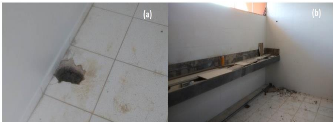
Figura 3: Alterações na obra: (a) abertura para passagem de tubulação entre dois andares (b) troca de revestimento.
