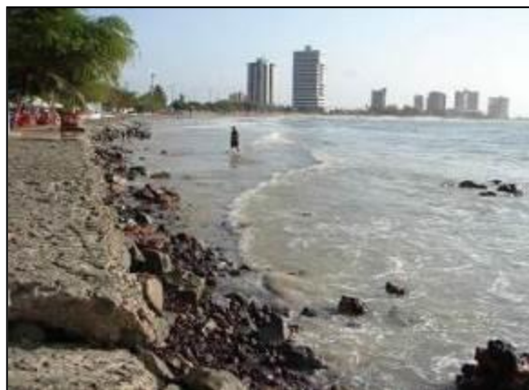
Figura 6- Obra de proteção na orla marítima na Praia da Ponta D'Areia
