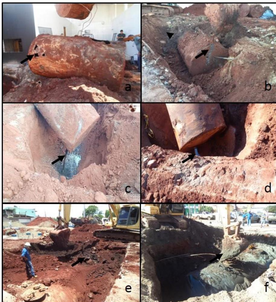
Figura 2 – Registro fotográfico do momento da remoção de SASC dos postos de combustíveis localizados nos municípios pertencentes ao IAT/ERLON de Londrina, Paraná. a) Tanque de gasolina com corrosão (seta); b) Tanque de gasolina com corrosão (seta) e solo escuro (ponta de seta); c-d) Líquido vazando de tanque no momento da remoção; e-f) solo com coloração escura. Fonte: o autor
