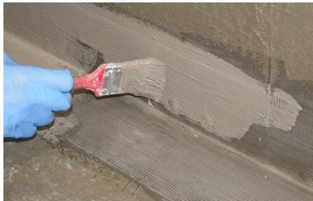
Figura 1 – Aplicação de produto do sistema Moldado in loco Fonte: AECWEB (2016)
