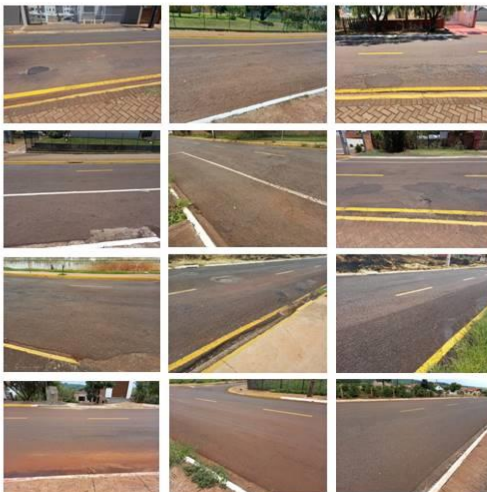
Figura 5 – Mosaico fotográfico da via analisada. Fonte: Autores (2021).
