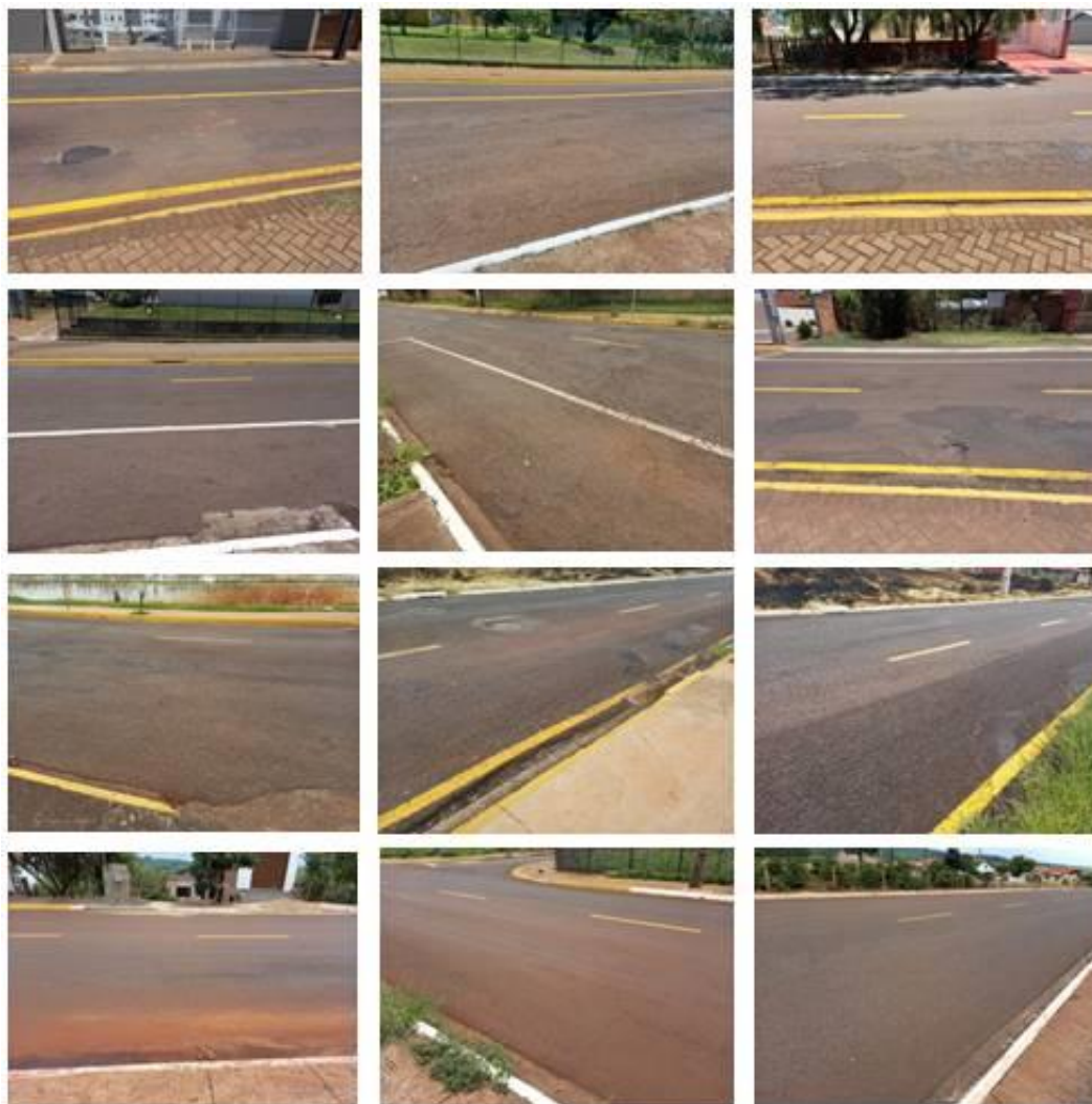
Figura 5 – Mosaico fotográfico da via analisada. Fonte: Autores (2021).
