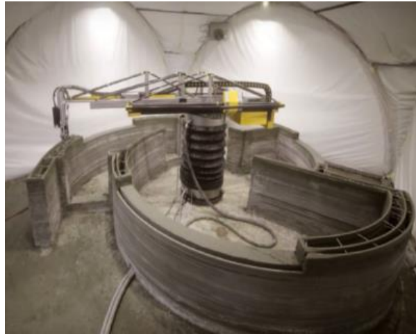
Figura 2 - Impressão 3D de concreto por um braço robótico fixo Fonte: EL Sayegh et al, (2020)
