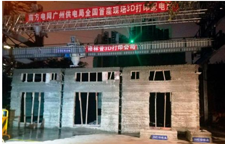
Figura 7 - Subestação de distribuição de energia sendo impressa
