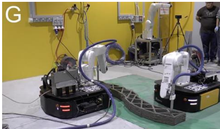
Figura 3 - Impressão 3D de concreto por um grupo de robôs móveis Fonte: Zhang et al, (2018)
