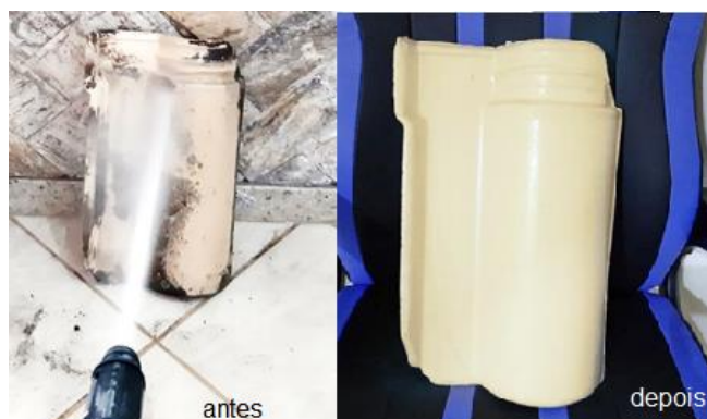
Figura 6 – Lavagem das telhas existentes.
