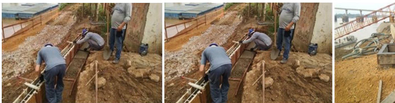
Figura 04 – a) Execução da viga e valeta; e b) Caixa de inspeção.
