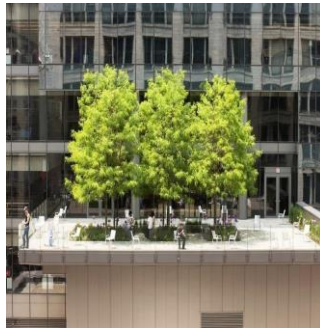
Figura 5 - Exemplo de Telhado Verde Intensivo
