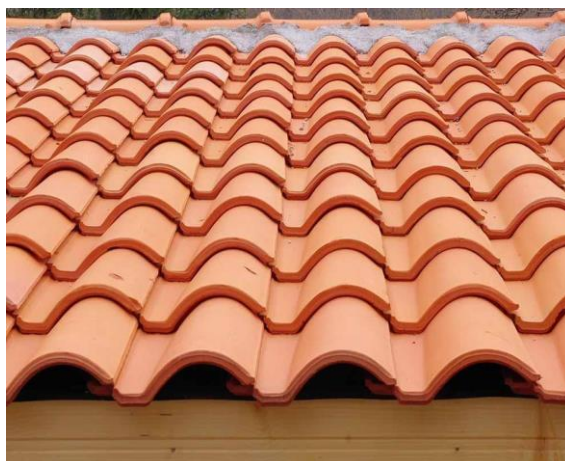
Figura 2 - Exemplo de telhado cerâmico
