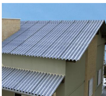
Figura 3 - exemplo de telhado de fibrocimento
