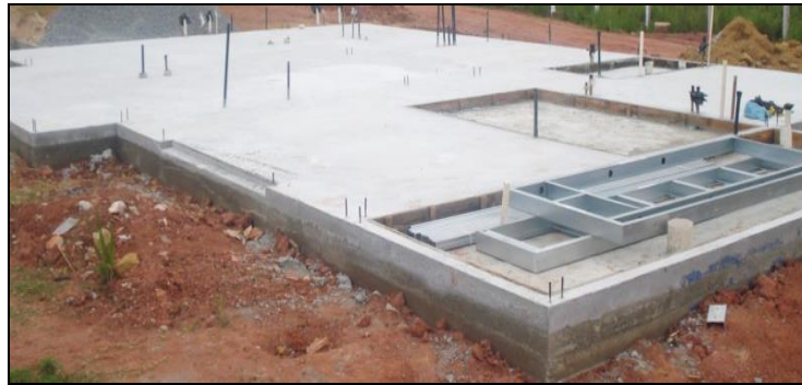
Figura 3. Fundação Radier (Steel Frame Brasil, 2018).
