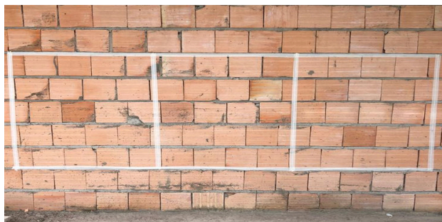
Figura 1 – Demarcação dos painéis com fita adesiva.
