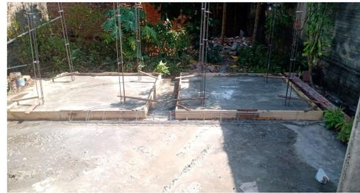
**Figura 2** - Etapas iniciais de fundação e estrutura de pilares.
