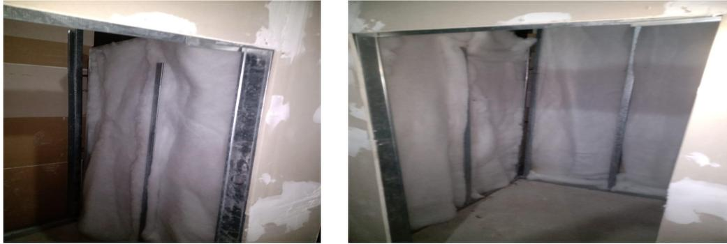
Figura 7 – Aplicação da lã pet de 25mm.
