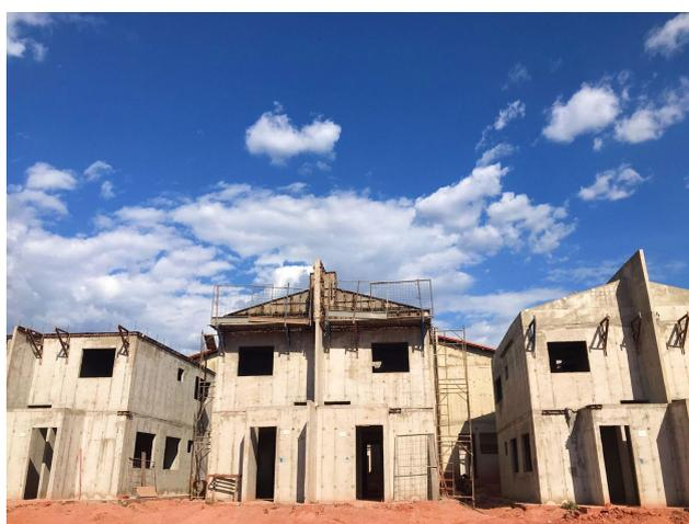
Figura 9: Montagem do pavimento platibanda. Fonte: Autoria própria (2022).
