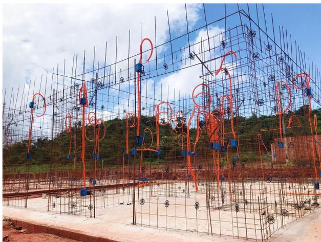
Figura 4: Instalações de embutidos elétricos no pavimento térreo. Fonte: Autoria própria (2022).
