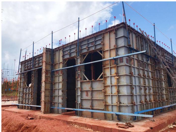
Figura 11: Forma metálica utilizando os alinhadores. Fonte: Autoria própria (2022).
