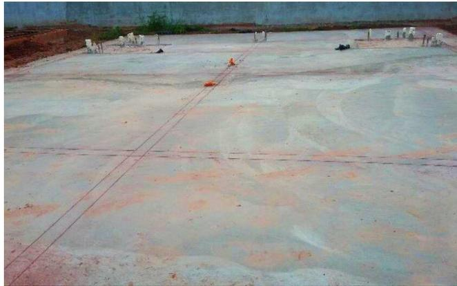
Figura 2: Marcação das paredes no radier. Fonte: Autor próprio (2022).
