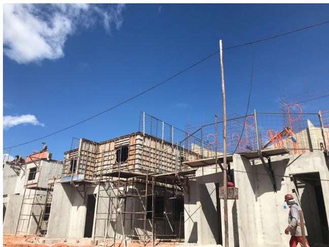
Figura 8: Montagem do pavimento superior. Fonte: Autoria própria (2022).
