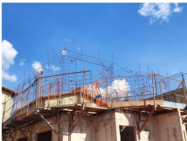
Figura 5: Instalações de embutidos elétricos no pavimento superior, juntamente com o sistema de proteção por meio de mão-francesas e plataformas. Fonte: Autoria própria (2022).
