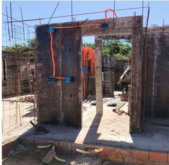
Figura 6: Placas com o desmoldante já aplicado. Fonte: Autoria própria (2022).
