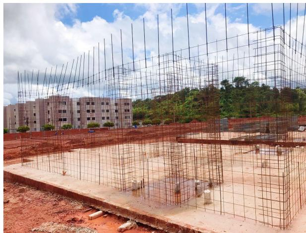
Figura 3: Montagem de armadura. Fonte: Autor próprio (2022).
