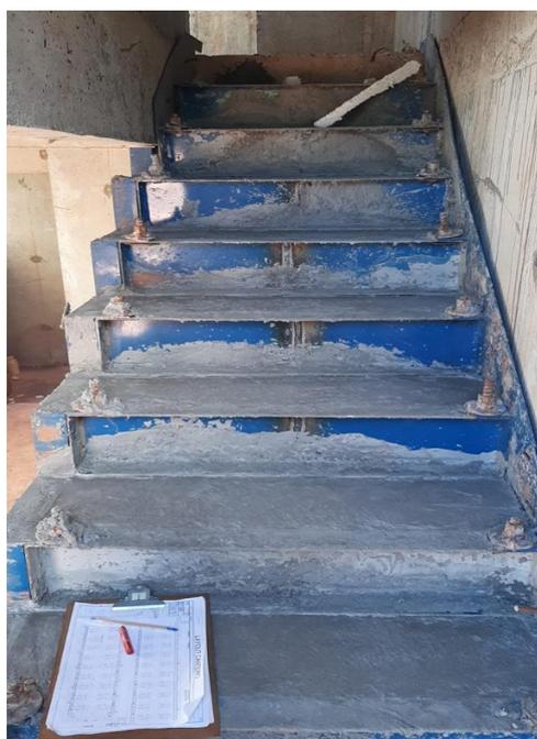
Figura 10: Forma metálica da escada, já concretada. Fonte: Autoria própria (2022).
