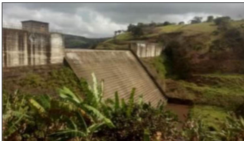
Figura 2 - Barragem Pau Ferro.
