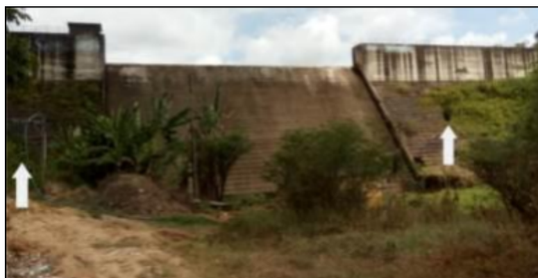
Figura 3 - Localização das galerias de drenagem na barragem.
